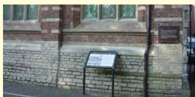
Nonnenbrug met het Academiegebouw. Rechts: gevel in baksteen en de plint van Gobertanger en Bentheimer zandsteen.
