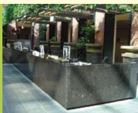
V.l.n.r.: Centrale hal Burgerzaken, Belgische hardsteen met brachiopodenschalen, crinoïden en koraalfragmenten.
