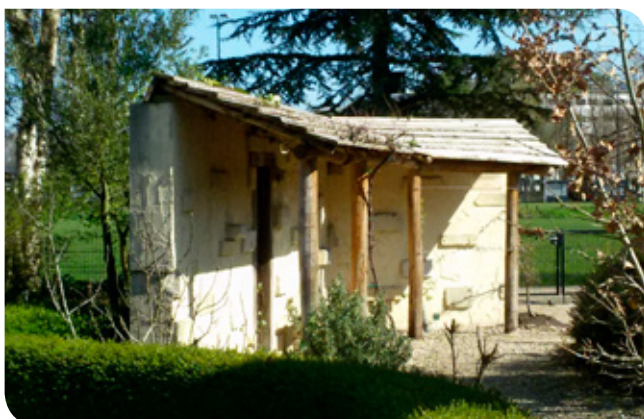
Mergelblokken in de wand van de schuilhoek.
